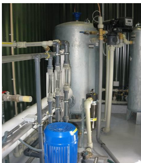
Joonis 4.12 Kuusiku puurkaevpumpla filtrid
