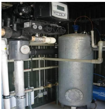
Joonis 4.11 Kodila puurkaevpumpla filtrid
