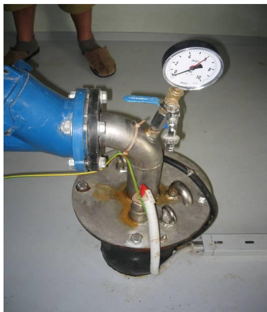
Joonis 4.4 Alu Sassiani puurkaevpumpla välisvaade ja puurkaevu päis
