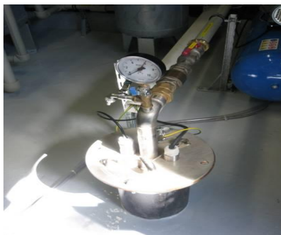
Joonis 4.8 Kuusiku puurkaevpumpla välisvaade ja puurkaevu päis
