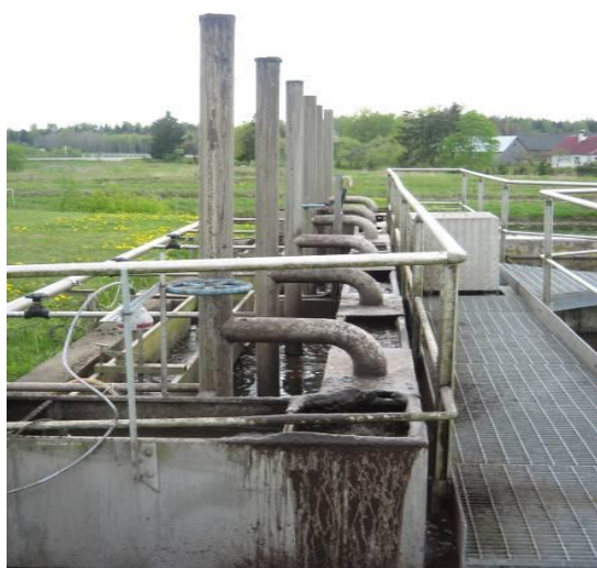
Joonis 5.3 Rapla linna reoveepuhasti aeratsioonibasseinid, järelsetiti ja mudatagastuskanal ja hoone
