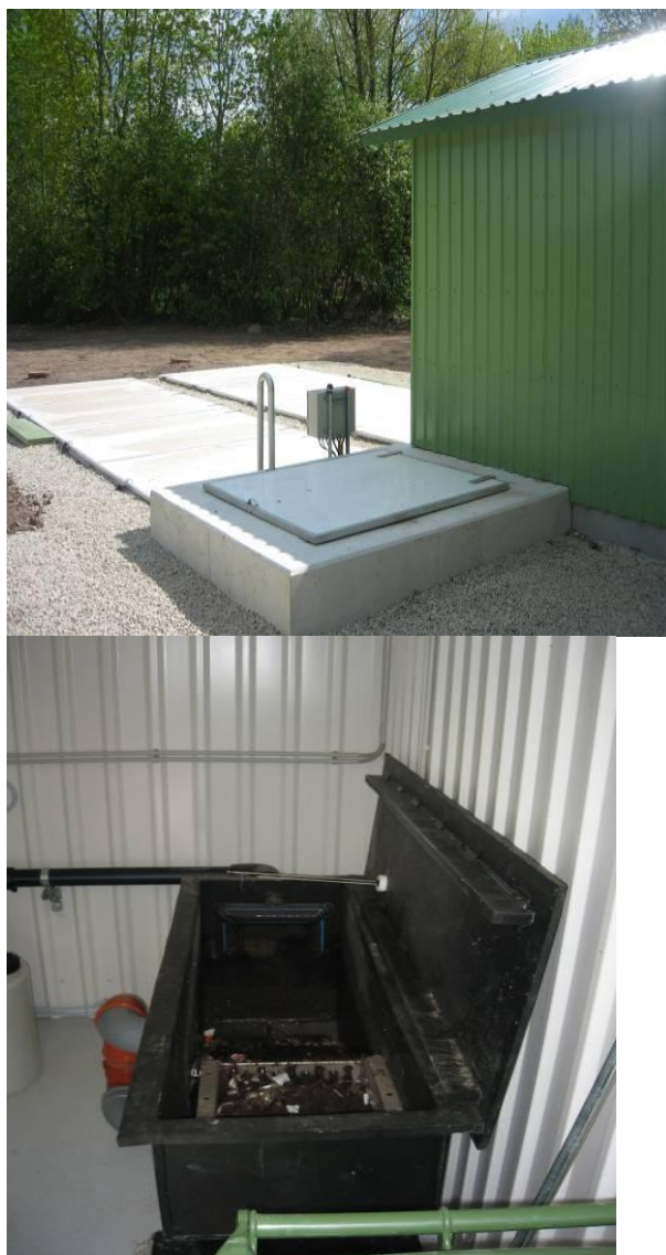
Joonis 5.10 Kuusiku reoveepuhasti välisvaade ja võre
