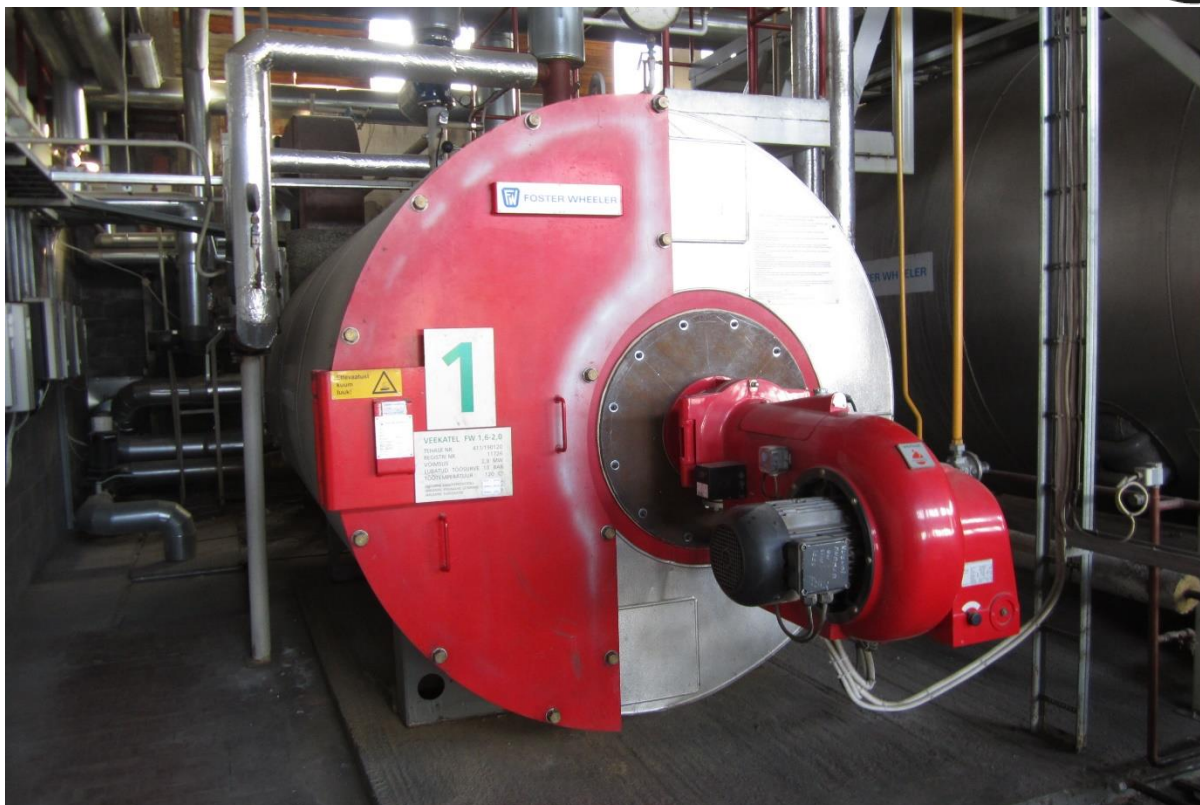
Joonis 2.3 Maagaasil töötav katel Foster Wheeler 16-20
