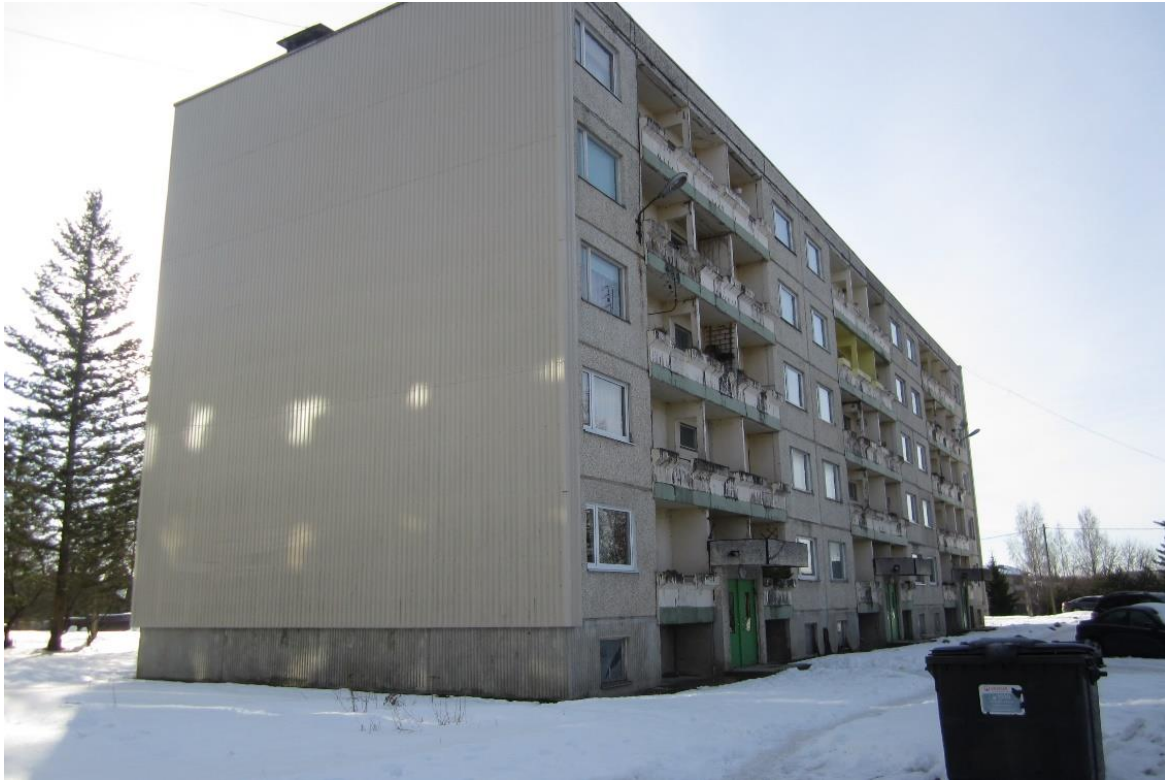
Joonis 2.9. Tallinna mnt 47 korterelamu, soojustatud vaid otsaseinad
