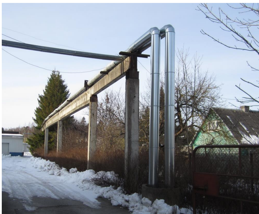
Joonis 2.5 Maapealsed kaugküttetorustikud
