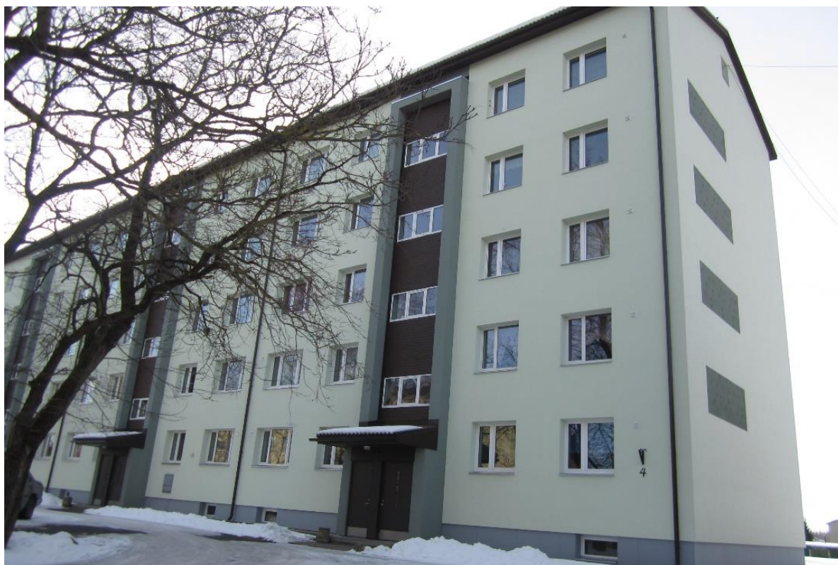
Joonis 2.8 Mahlamäe 4 renoveeritud korterelamu
