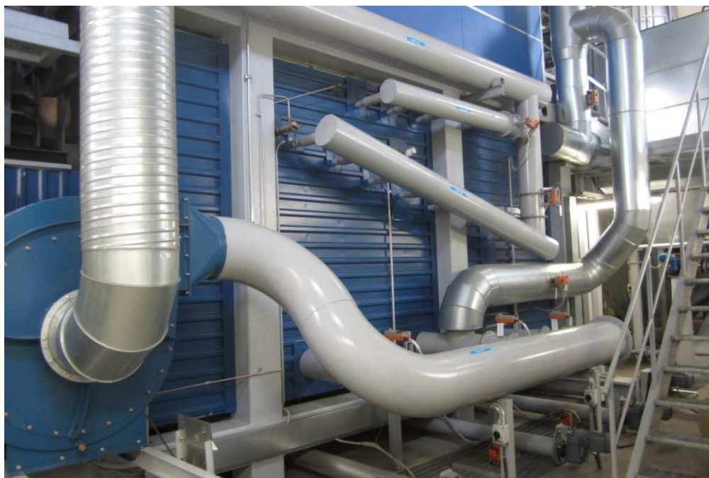
Joonis 2.2 Hakkpuidu katel Danstoker VHS 25+900
