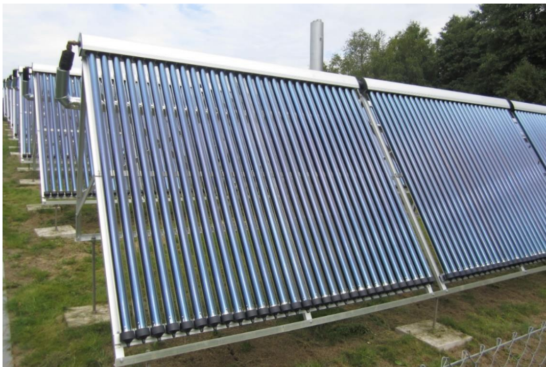
Joonis 5.1. Päikesepaneelid sooja vee tootmiseks
